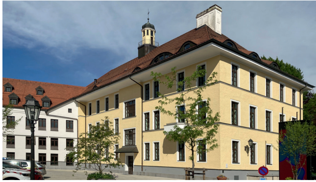
Landratsamt Traunstein, Hauptgebäude
